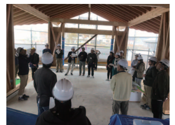
施工事業者より現状の報告
