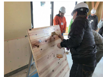
防腐剂を塗装【外部倉庫WS】
