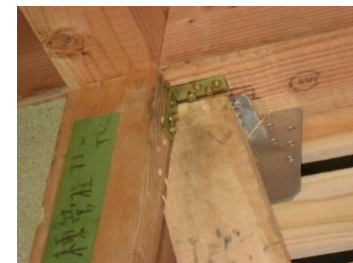
接合部 ※天井裏等から撮影
