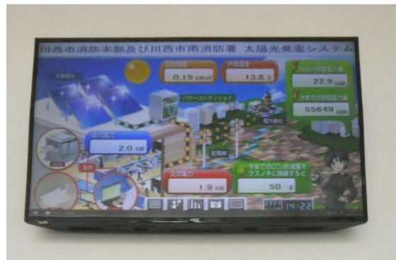
太陽光発電システム確認モニター
