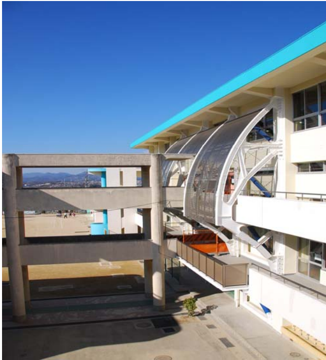
※明峰小学校耐震補強工事完成写真
