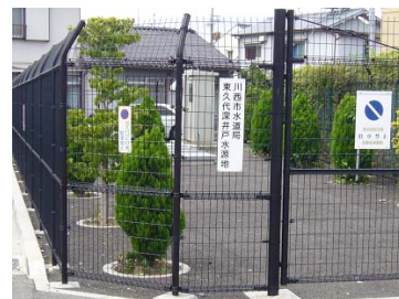
東久代水源地 (深井戸)
