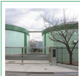
滝山配水池（1・2号）は17・18年度に耐震化工事済みです
