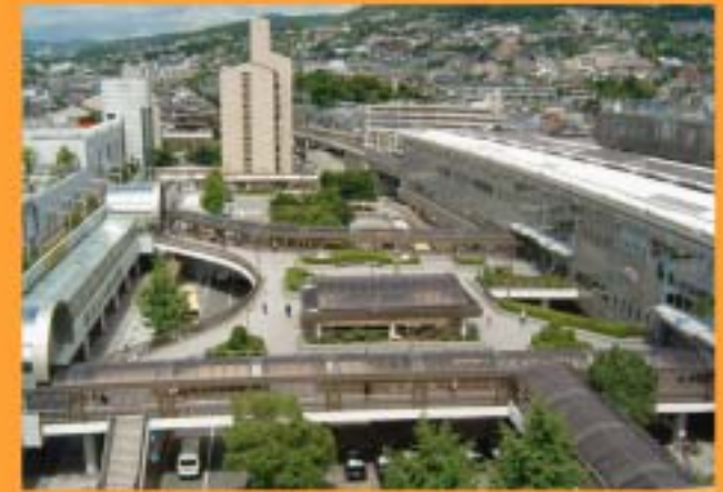
川西能勢口駅及び南側駅前広場
