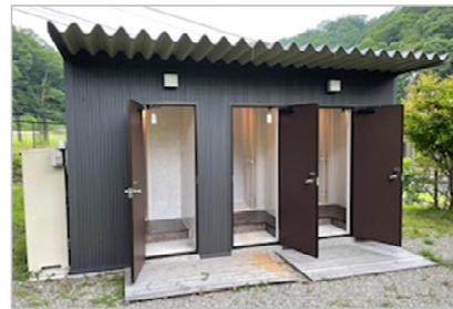
シャワー室(修繕後)
