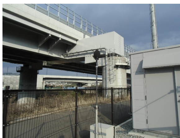
【図 7-3 測定の様子（川西文珠橋局）】
