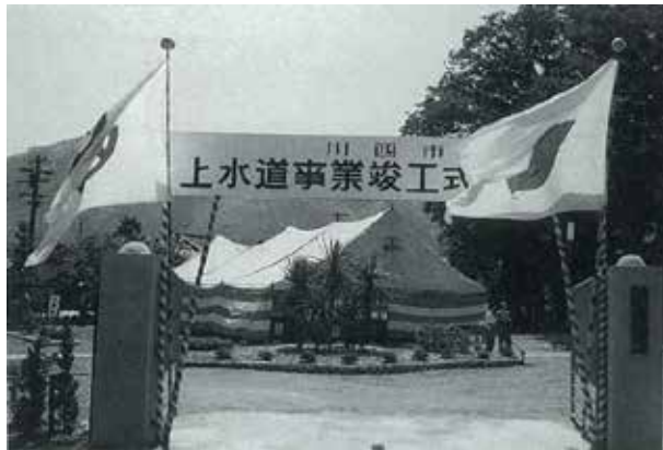
創設期における松山浄水場竣工式風景（昭和 32 年（1957 年）11 月）
