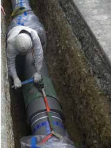
送配水管の耐震化工事
