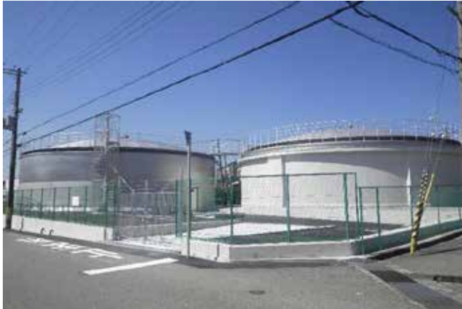
更新された大和低区配水池
