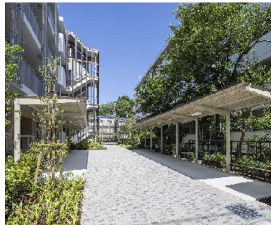
花屋敷団地 北側 外構部分
