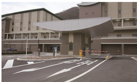
国崎クリーンセンター計量棟
