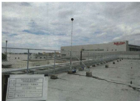
測定機器設置状況（川西南中学校）
