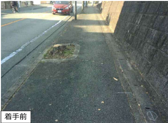
市道950号（西多田地内） 舗装復旧（根上り段差解消13箇所）
