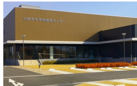
川西市中学校給食センター（久代）
