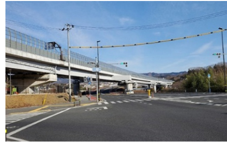
新名神高速道路と県道川西インター線（石道・西畦野・東畦野）
