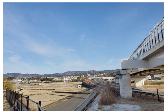
新名神高速道路川西インターチェンジ周辺
