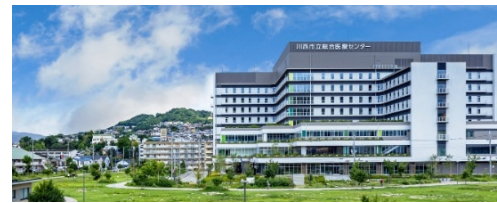
川西市立総合医療センター（火打）
