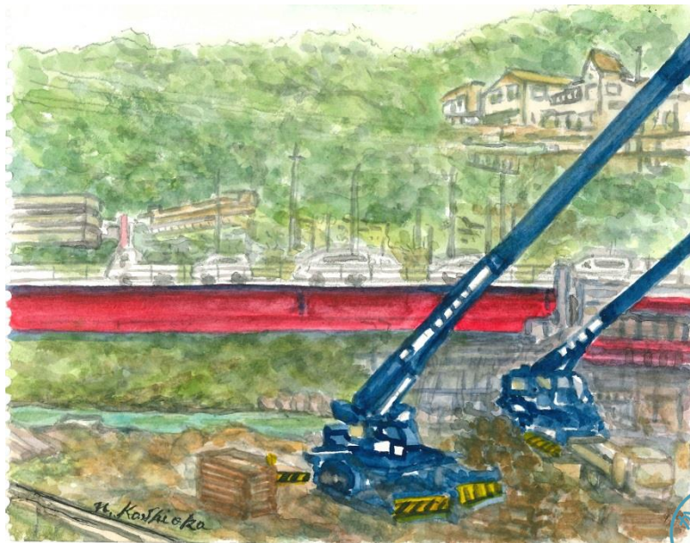
「工事中の多田大橋」 川西市多田院
