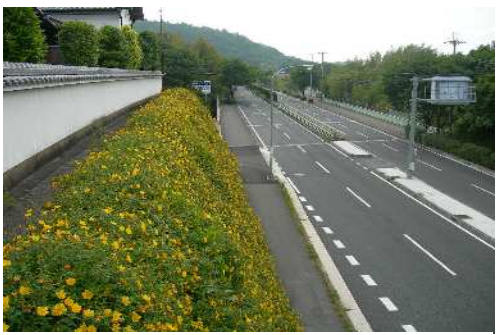
⑩ 幹線沿いの植樹帯 (西多田)
